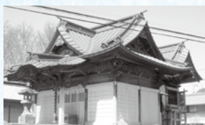
(写真4) 修理が完成した社殿
